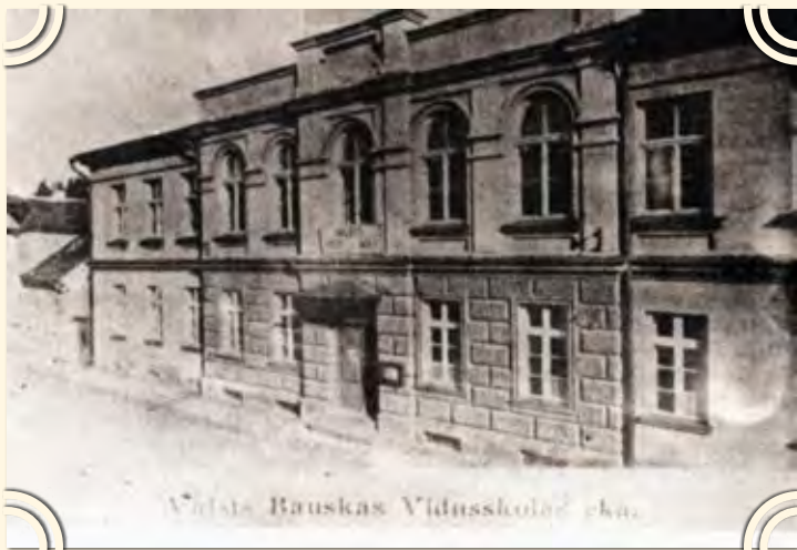
- Bauskas Valsts vidusskolas ēka (foto no Bauskas Novadpētniecības un mākslas muzeja krājuma)
